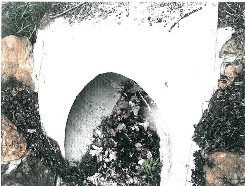
Příloha č. 15: Drobné žabky překonávají trvalé zábrany i po hladkých jen mírně zkosených stěnách
