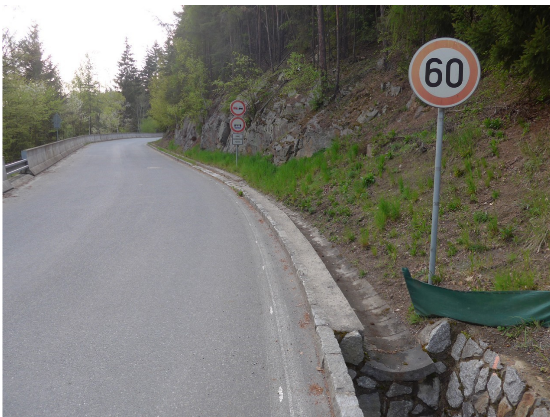
Sjezd u autobusové zastávky, zařízení vodní nádrže, nefunkční rošt a betonové zábrany na levé straně
