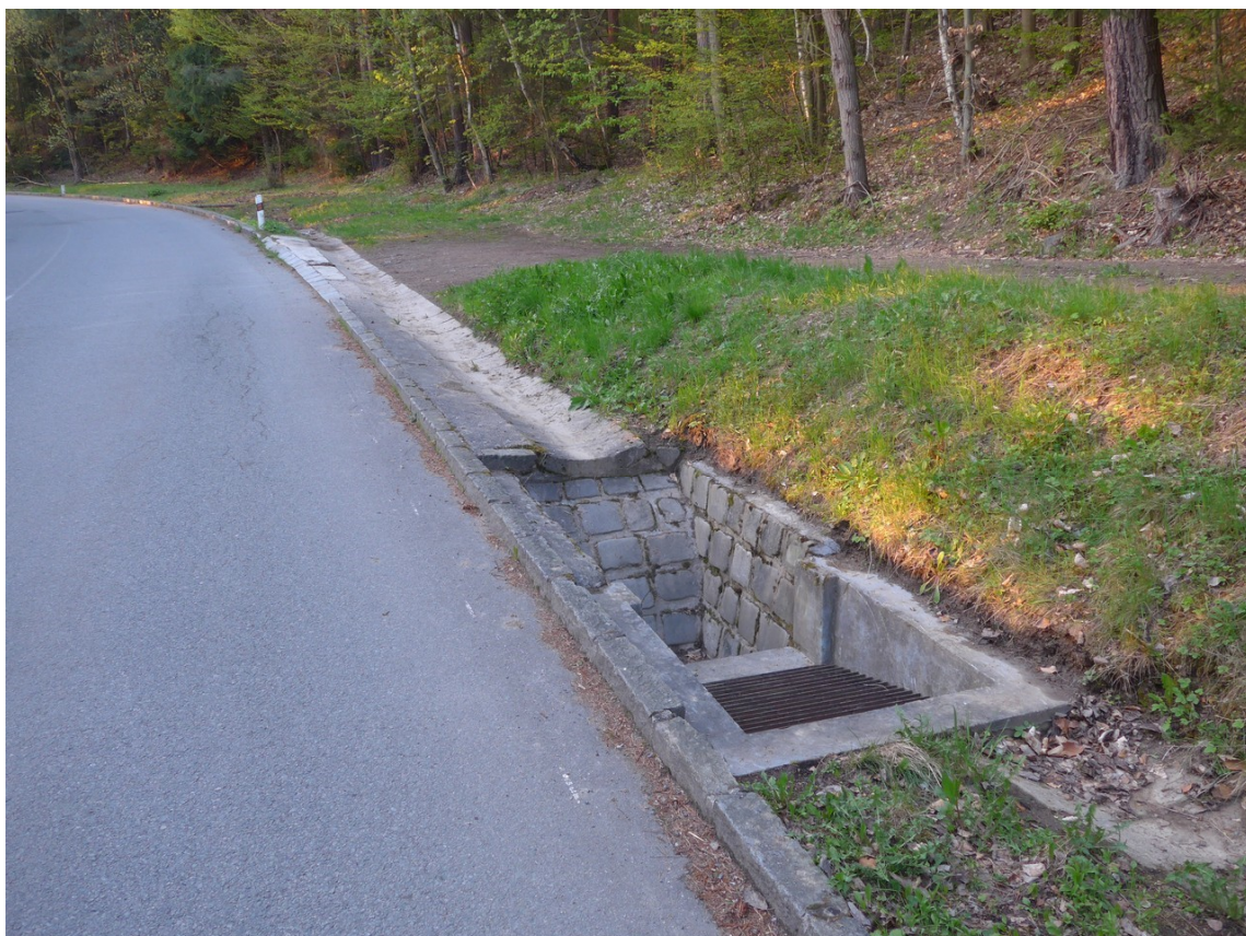
Manipulační plocha, sjez do lesa a nevyužitelný propustek - lapol
