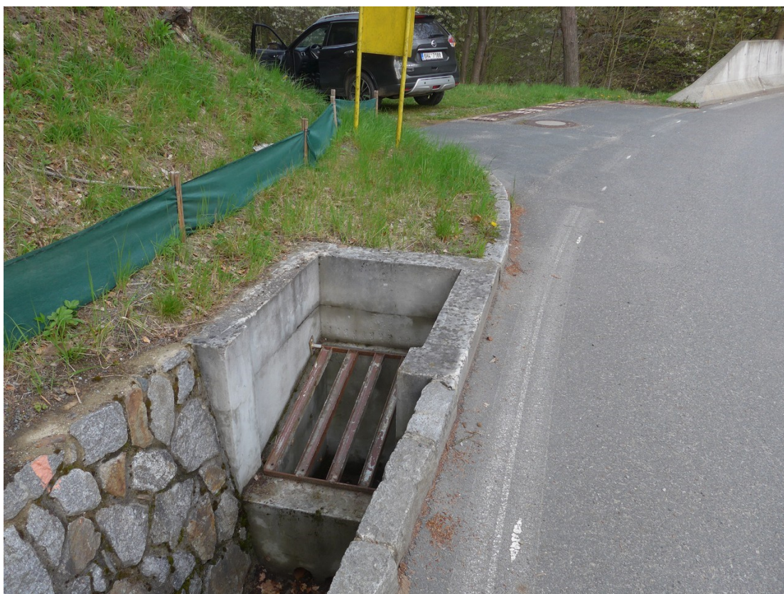
Sjezd u autobusové zastávky, zařízení vodní nádrže, nefunkční rošt a betonové zábrany na levé straně
