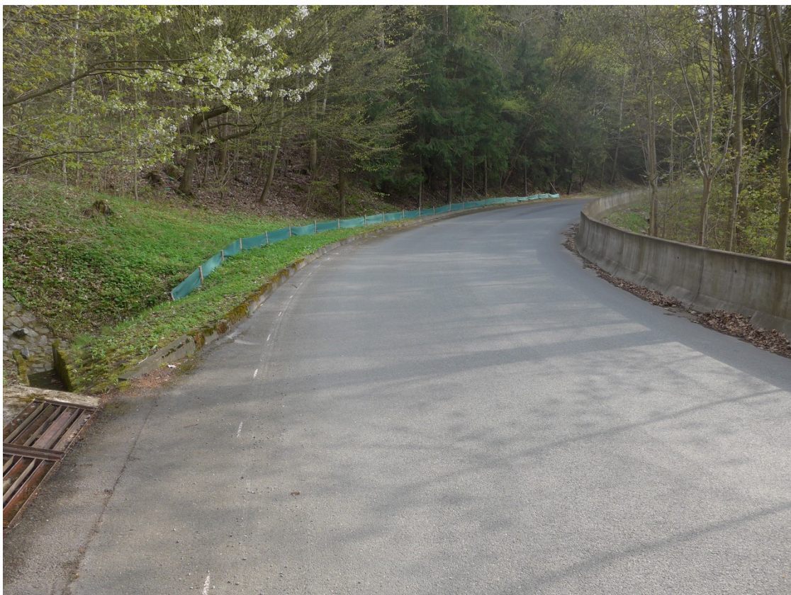
Celkový pohled na sjezd a místo propustku
