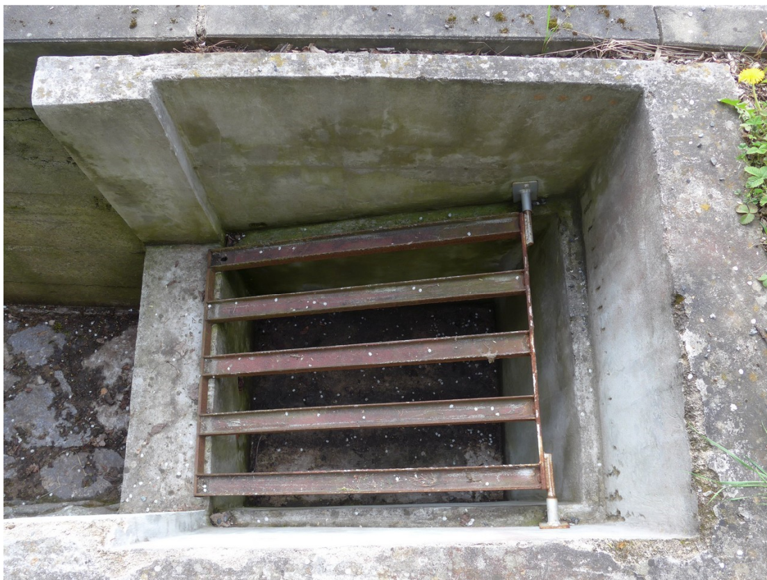
Propustek – lapol je dvoukomorový, část s odklápěcí mříží obsahuje vlastní troubu
