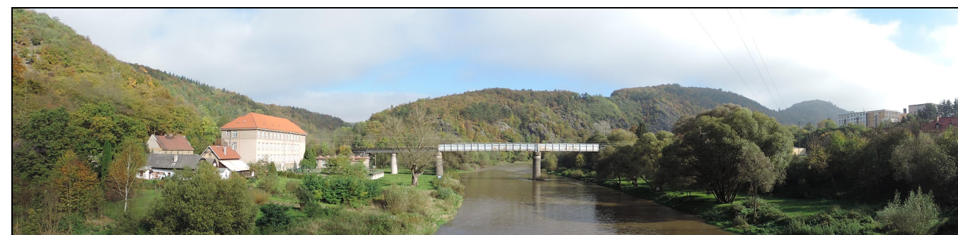
obr. B.33: Pohled po proudu řeky z mostu v Roztokách; v levé části snímku stará kola; řeka přetíná flezební most
